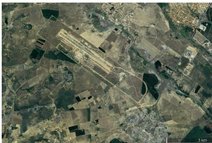
Figura 5 - Novo Aeroporto de Vitória da Conquista Glauber Rocha - Em Construção
