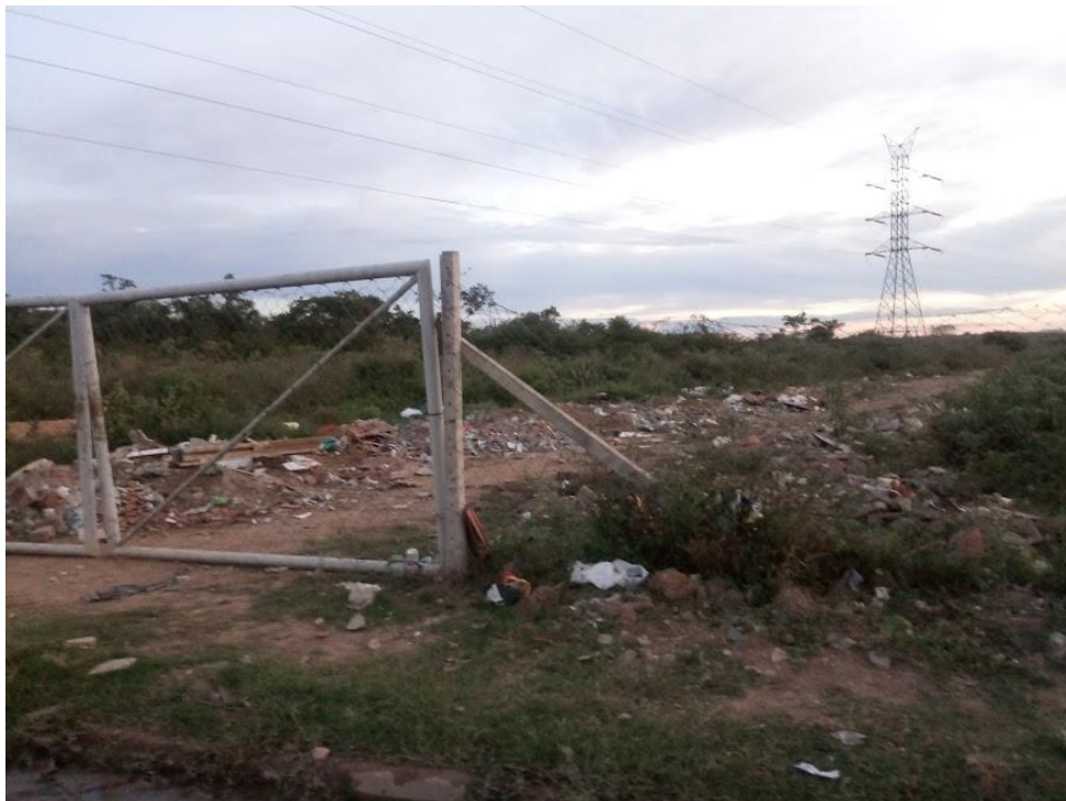
Figura 21 - Acúmulo de entulho no Loteamento Vila Sul
