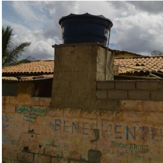
Figura 14 - Reservatório residencial_Bairro Jatobá
