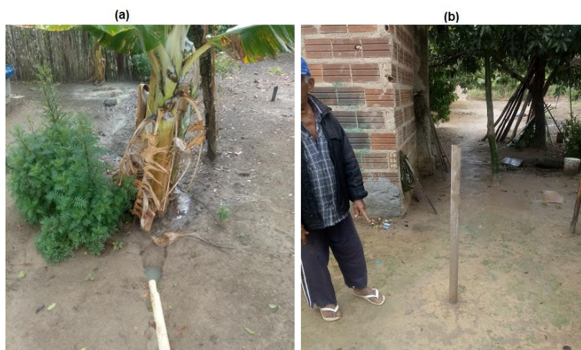
Figura 16 Assentamento Zumbi dos Palmares (a) disposição de águas cinzas no terreno (b) fossa absorvente
