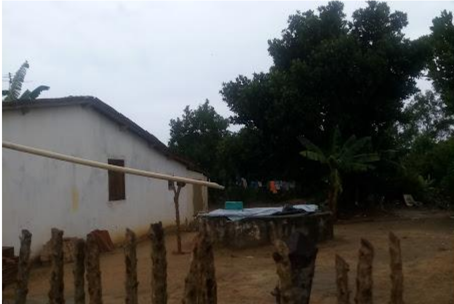
Figura 13 - Cisterna de aproveitamento de água da chuva_Assentamento de Moradores União e força
