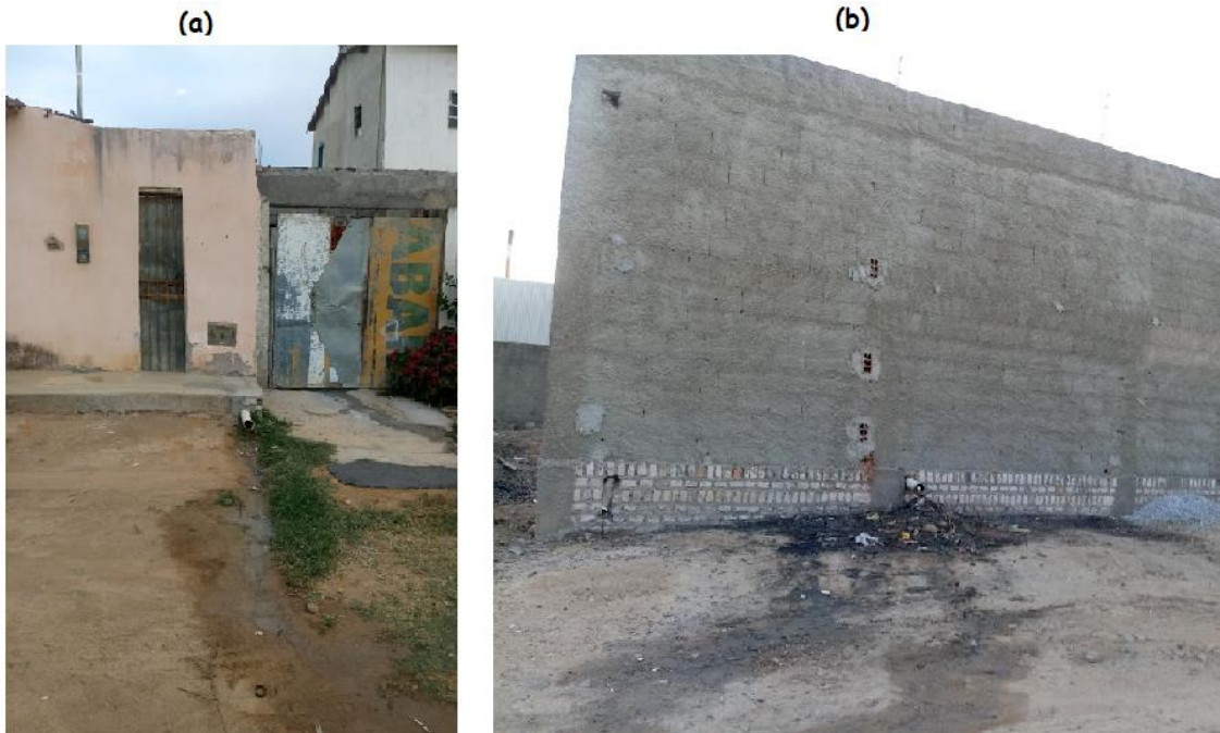
Figura 15 - Loteamento Parque Conveima (a) Lançamento de esgoto a céu aberto de residência (b) lançamento de esgoto a céu aberto da fábrica de biscoitos.
