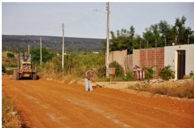
Terraplanagem no Bairro Boa Vista
