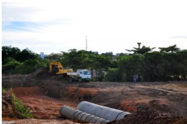
Construção de um canal de escoamento de água no Bairro Conquistinha
