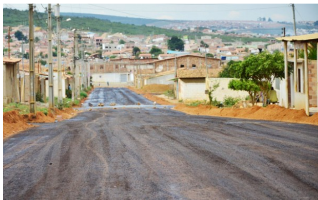
Avenidas Apaches e Dois se preparam para receber o asfalto
