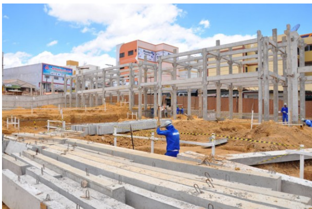
Novo ambiente vai contribuir para a modernização do Centro Comercial da cidade
