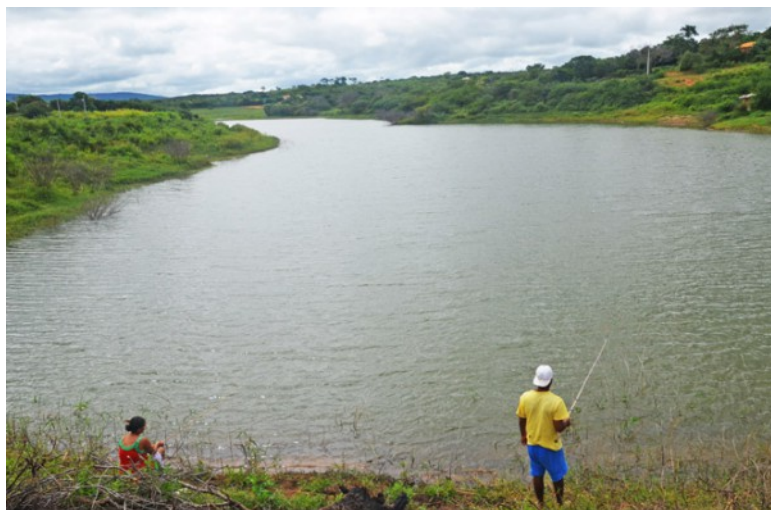
Barragem na região da Roseira
