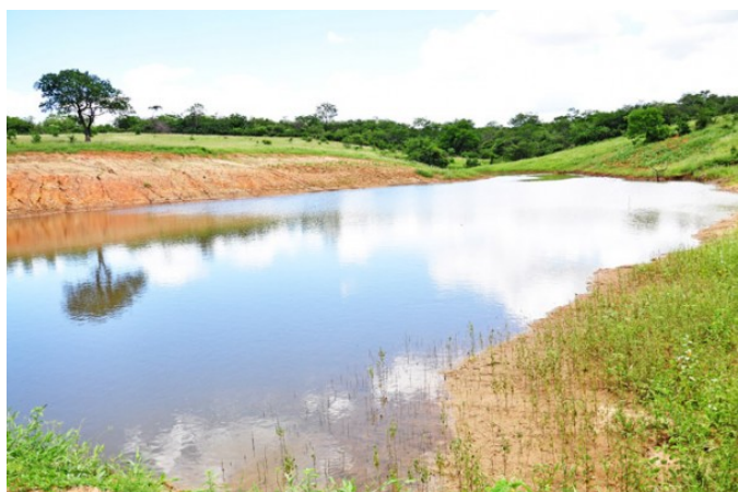
Barragem em Pindoba
